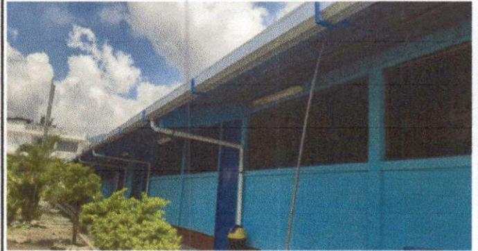
Foto 8: Sustitución de canal de metal
