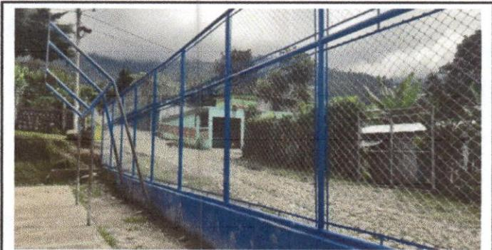
Foto 12: Reparación de tubo hg y malla galvanizada
