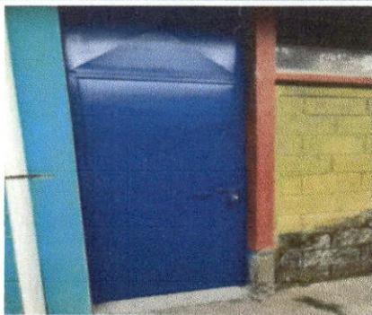
**Foto 5: Mantenimiento a estructura (lijada, cambio de tubo, cepillado, sujeciones, aplicación de pintura)**
